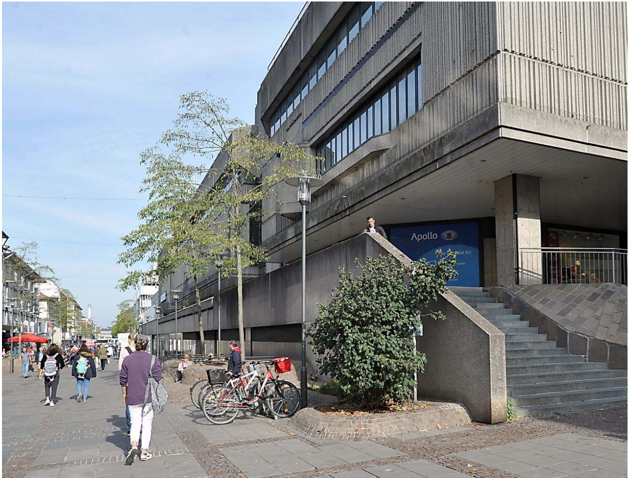
Ausbaufähig: die Fassade des Luisencenters © Cornelia Sick
